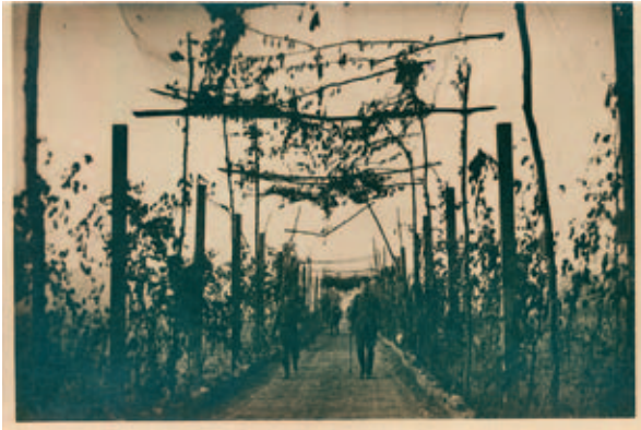
Ein Bohlenweg über den Forges-Bach, aufgenommen im Herbst 1916: Nicht nur die schweren Kampfhandlungen, sondern auch allnächtliches Artilleriefeuer hatten das Forges-Bachtal rasch in eine hunderte Meter breite Sumpffläche verwandelt. Um Soldaten, Munition, Verpflegung und Baumaterial herüber zu bringen, errichteten die deutschen Truppen befestigte Fahrstraßen aus Holzbohlen.
