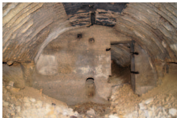
Der Innenraum eines betonierten und in die Erde versenkten deutschen Unterstandes im Forges-Wald: Mit Wellblech ausgekleidet und einer dicken Betonschicht überzogen, bot er den deutschen Soldaten über Jahre hinweg eine sichere Unterkunft.
