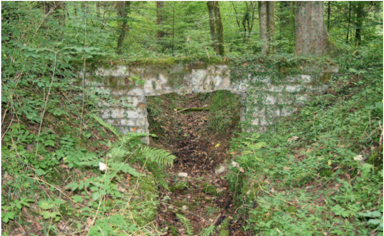
Überreste eines ausgemauerten Einganges in den Gallwitz-Tunnel, durch den in der frühen Nachkriegszeit Besucher in die ausgedehnte unterirdische Anlage geführt wurden. Sie besichtigten in Friedenszeiten einen Ort, an dem fast ein Jahr lang hunderte deutsche Soldaten Schutz gefunden hatten und der überdies einen Verbandplatz, Küchen, Depots und weitere Einrichtungen beherbergte.
