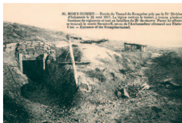
Blick auf einen Nebeneingang in eine der insgesamt drei großen deutschen Tunnelanlagen auf dem Toten Mann: Diese Aufnahme stammt aus der frühen Nachkriegszeit. Sie zeigt nicht zuletzt eindrucksvoll das völlig deckungslose Gelände, noch übersät von Ausrüstungsgegenständen.
