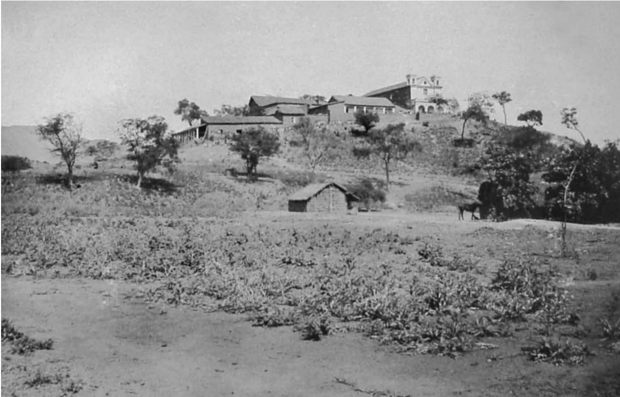
Misión de Santa Rosa de Cuevo vista desde el norte, 1898. Fuente: Fotografía en Giannecchini y Mascio 1995 [1898], fotografía n° 83.
