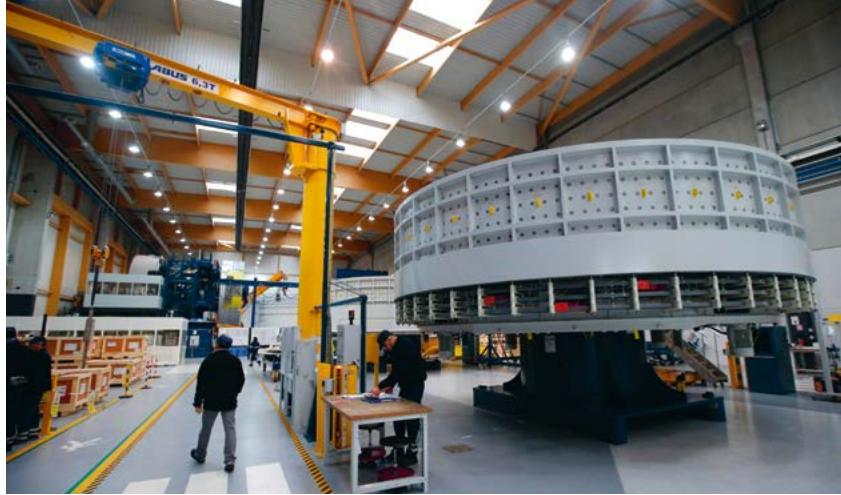
Das General Electric-Montagewerk für Offshore-Windkraft in Montoir-de-Bretagne, in der Nähe von Saint-Nazaire, in Westfrankreich. Quelle: © Stephane Mahe, Reuters
