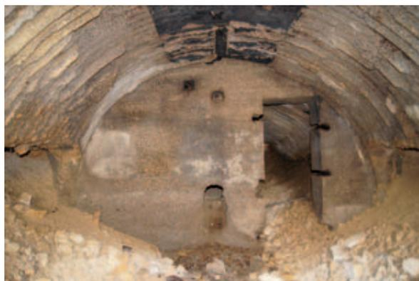
L'intérieur d'un abri allemand bétonné, creusé dans la terre dans le bois de Forges : Revêtu de tôles ondulées et recouvert d'une épaisse couche de béton, il a, pendant des années, servi d'hébergement sûr aux soldats allemands.
