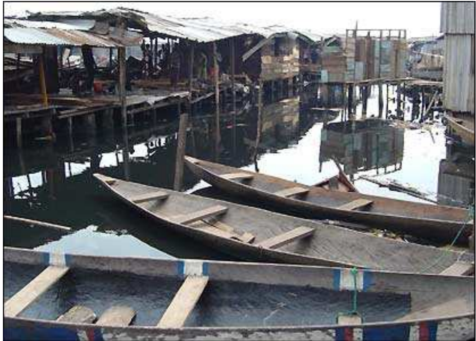
Makoko – Ein auf Stelzen gebautes Viertel nahe der Lagune in Lagos Foto: Anna Borzello, BBC
