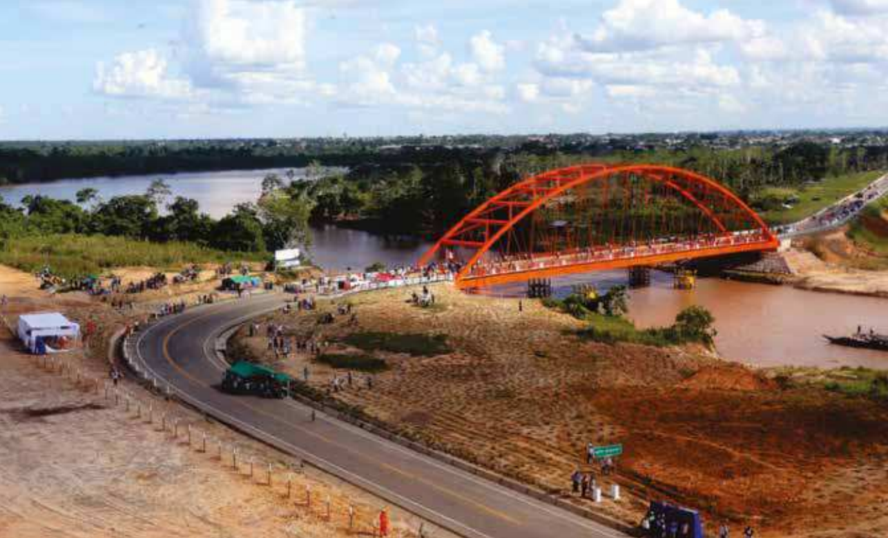
Proyecto vial "Acceso al Nuevo Puerto de Yurimaguas" que es el último tramo de la Concesión IIRSA Norte en Perú
