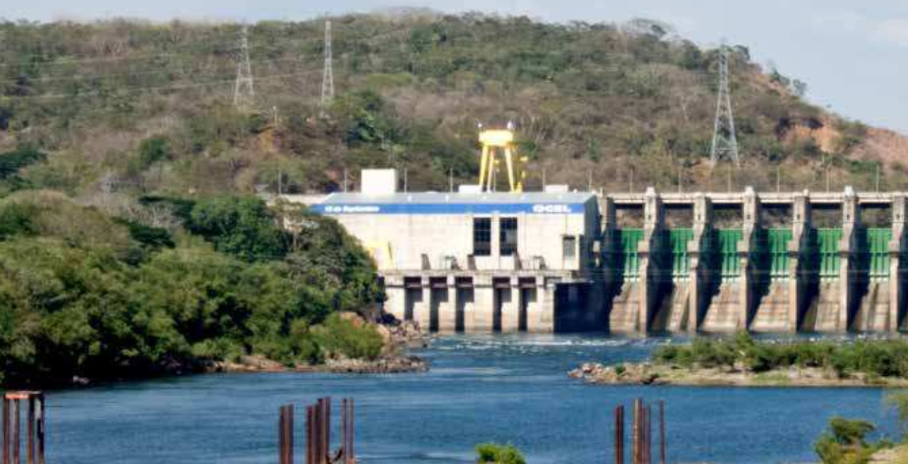
Presa 5 de Noviembre del Río Lempa, El Salvador
