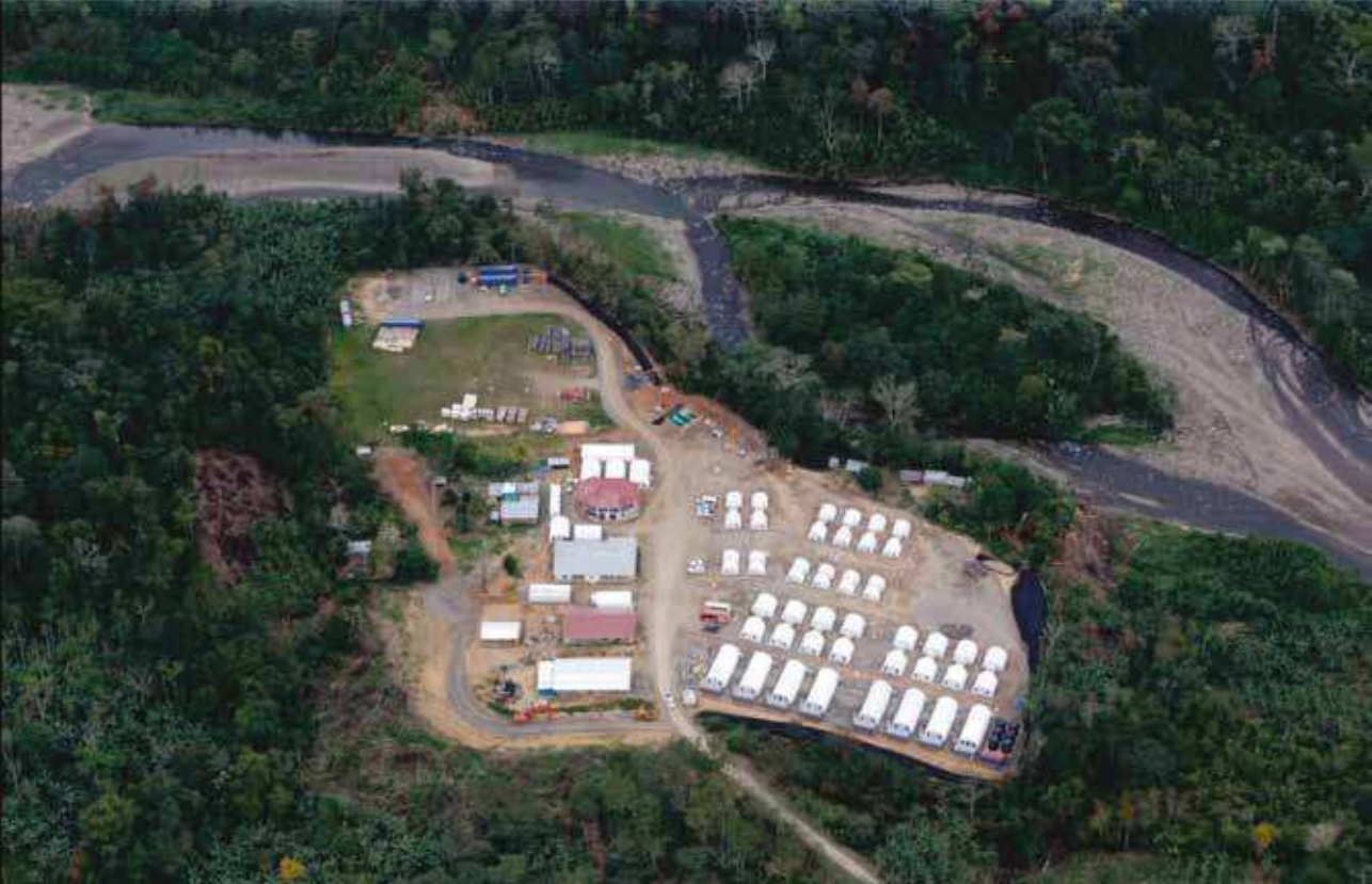
Parte de las instalaciones del el eje energético de La Convención en Cusco, Perú
