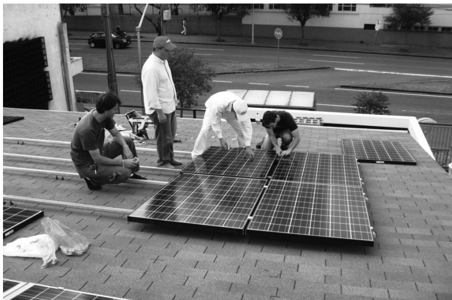
FIGURA 05. Instalação do Sistema Fotovoltaico do Escritório Verde da UTFPR
