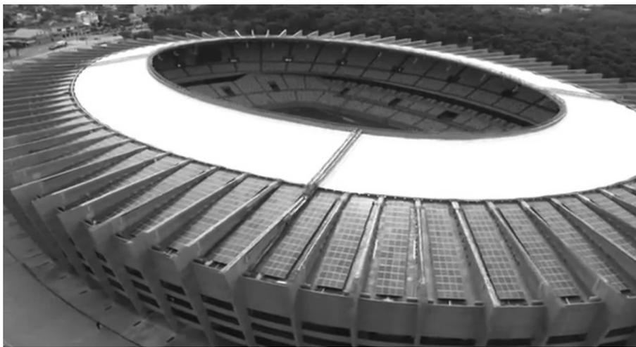
FIGURA 4: O Estádio do Mineirão Solar em Belo Horizonte-MG é o maior estádio de futebol do Brasil com integração solar fotovoltaica (1.400 kW) na cobertura das arquibancadas (<http://www.americadosol.org/mineirao-solar/>).
