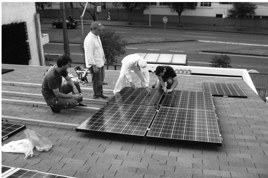
FIGURA 06. Módulos fotovoltaicos instalados e inversor
