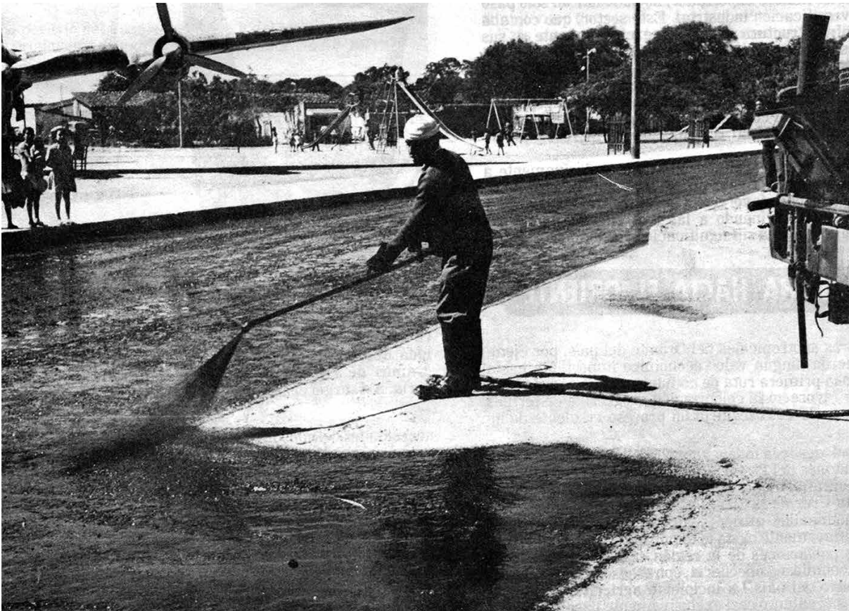
Avance de Asfaltado del Primer Anillo, 1977.
