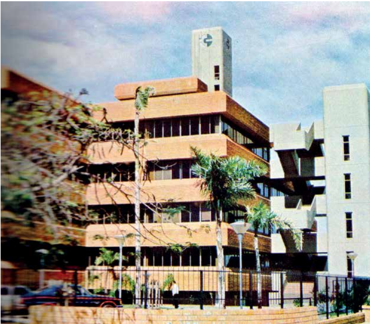
Construcción del edificio de la Corporación de Desarrollo de Santa Cruz, 1986. Fuente: Colección Traverso.
