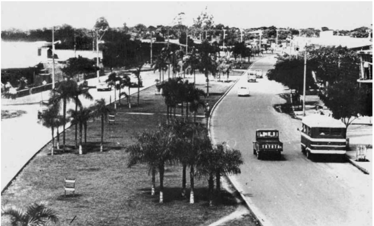
Pavimentación: Obras de urbanismo en Santa Cruz de la Sierra, 1972. Fuente: Colección Traverso.
